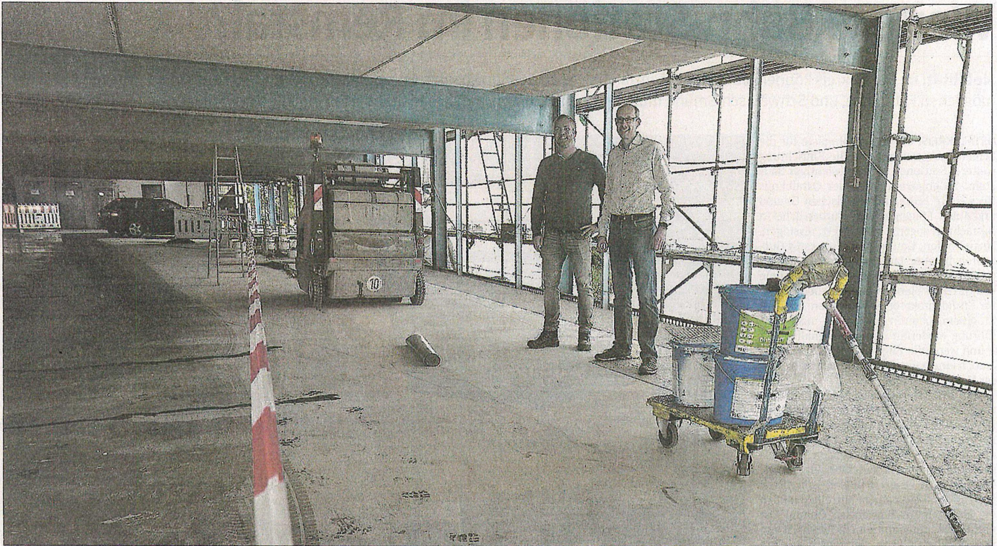
Abteilungsleiter Planung und Hochbau Bernd Arnold und Bautechniker vom Amt für Gebäudewirtschaft Steffen Hägele berichten über den aktuellen Sanierungsstand des Fehrle-Parkhauses und zeigen die Arbeiten im dritten Bauabschnitt. Fotos: Astavi
