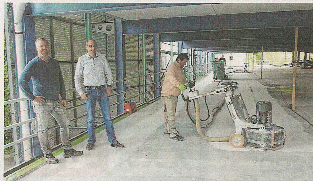
Baustelle statt Parken: Im Fehrle-Parkhaus am Gmünder Bahnhof bringen Bauleute der Firma Schmid einen neuen Belag auf. Steffen Hägele und Bernd Arnold (von links) erläutern die Maßnahme. Foto: Tom
